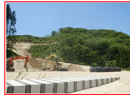
④施工：刈屋建設
