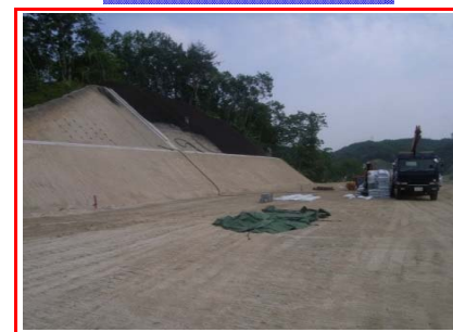
③施工：樋下建設
