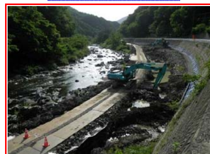
⑦施工：大成建設
