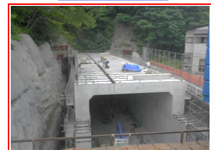
①施工：森本組
